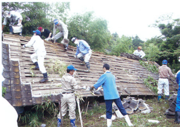
納屋の解体作業を行う職員
