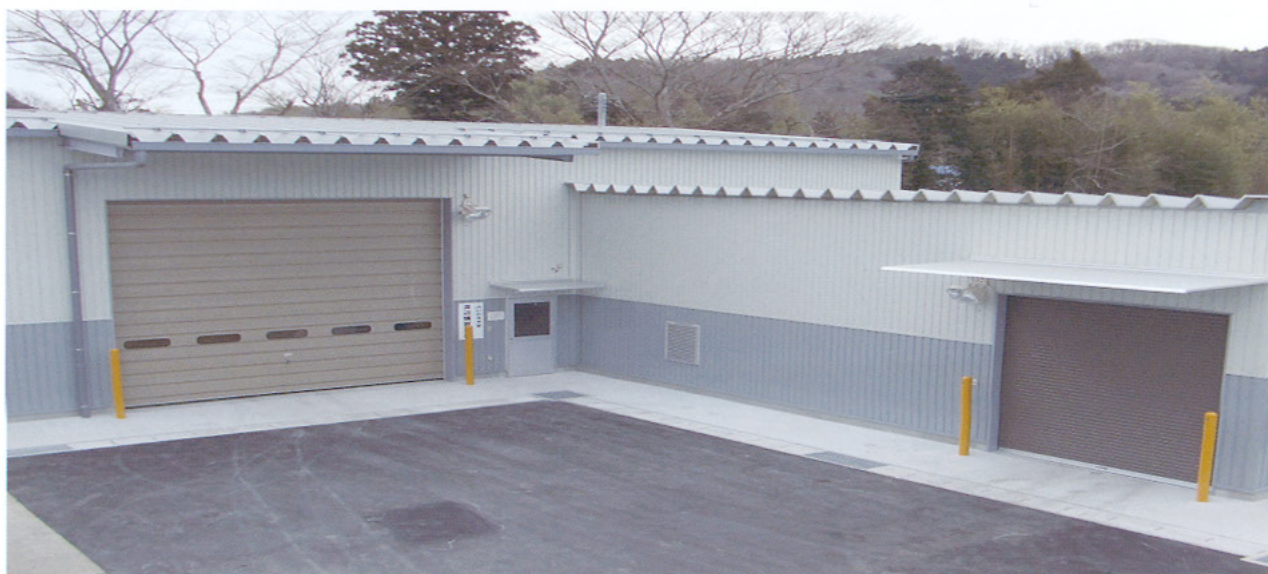
新築オープンした渡辺購買倉庫
