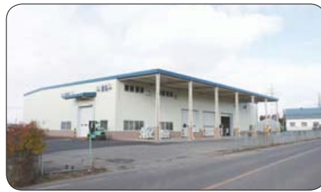
【西袋31号低温農業倉庫】
