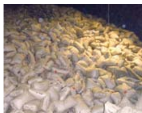
中島農業倉庫はい崩れ
